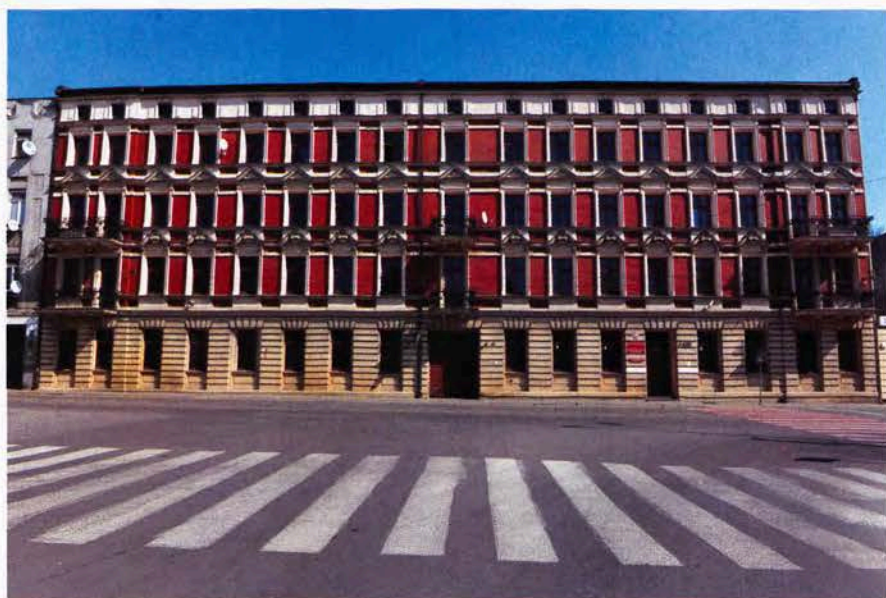
Siedziba Prokuratury Okręgowej przy ul. Kilińskiego w Łodzi, zamykająca ul. Wigury
