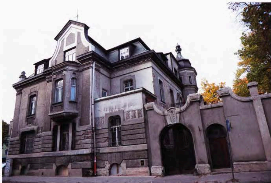
Plac Dąbrowskiego. Rezydencja Kestenbergów, elewacja południowa
