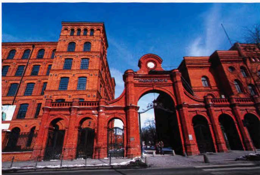
Brama Manufaktury, widok od ulicy Ogrodowej
