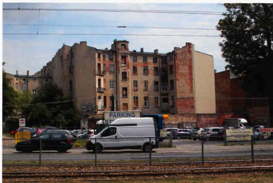
ul. Zachodnia, odsłonięte oficyny po wyburzonych pierzejach
