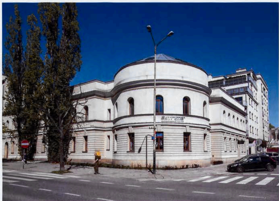
Budynek dawnej łaźni miejskiej na rogu ulic Nawrot i Wodnej
