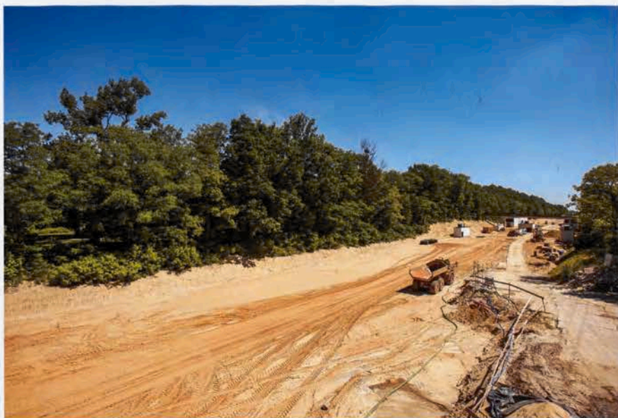
Widok z wiaduktu na ulicy Kopcińskiego na Park 3 Maja i budowę podziemnej linii kolejowej
