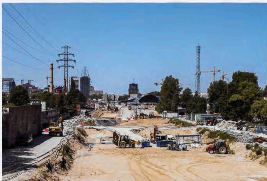
Widok z wiaduktu na ulicy Kopcińskiego na budowę Nowego Centrum Łodzi
