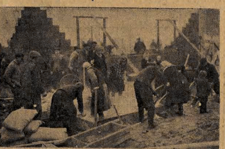
Pracownicy fizyczni i umysłowi PPB w Warszawie poświęcili niedzielę na budowę szkoły we wsi Pudry Stare, powiat Pułtusk. Szkołę tę wybudowano w stanie surowym w ciągu jednej niedzieli. Na jej ujęciu — praca przy budowie szkoły.
