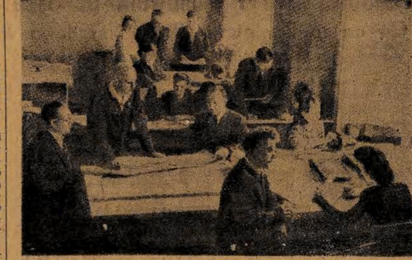
Grupa inżynierów budownictwa wodnego w Kujbyszewie — już przystąpiła do szczegółowego opracowania — gotowych w głównym zarysie planów gigantycznej tamy na Woldze.
