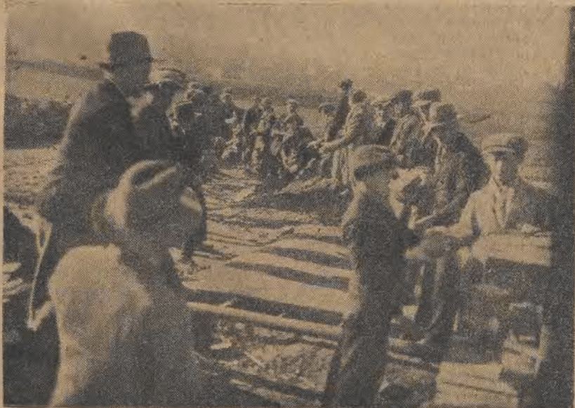
Budowa domu U. L. w Gaci 1935—36 r.
