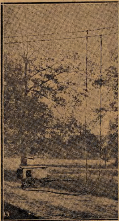
Połączenie między przewoźnym motorem elektrycznym, a przewodami.
