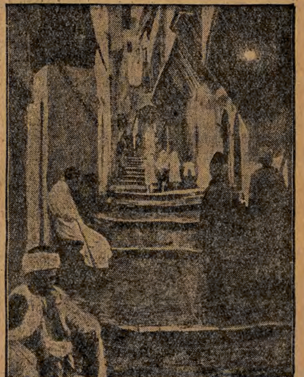
Hier wurden 60 Leute unter den Trümmern begraben. Die Straße in Algier, in der vor einigen Tagen durch einen Erdbeben 60 Personen unter den Trümmern der einstürzenden Häuser begraben wurden. Viele Personen fanden dabei den Tod.
