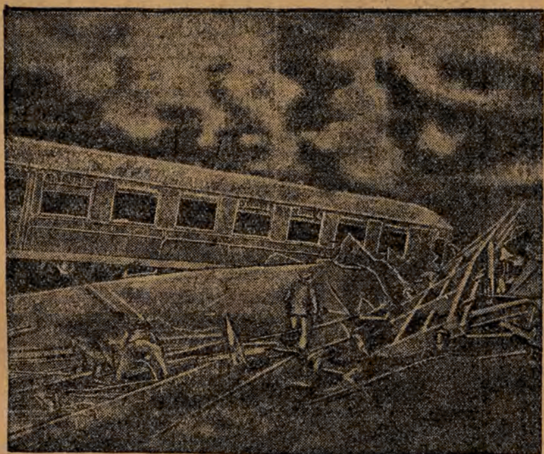
Entgleisung des „Fliegenden Schotten“.
