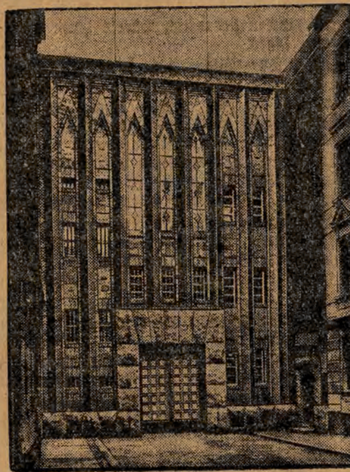
Vorderfront des neuen Gefängnisses in Liegnitz (Klinkerbau mit Dolomitblöcken).
