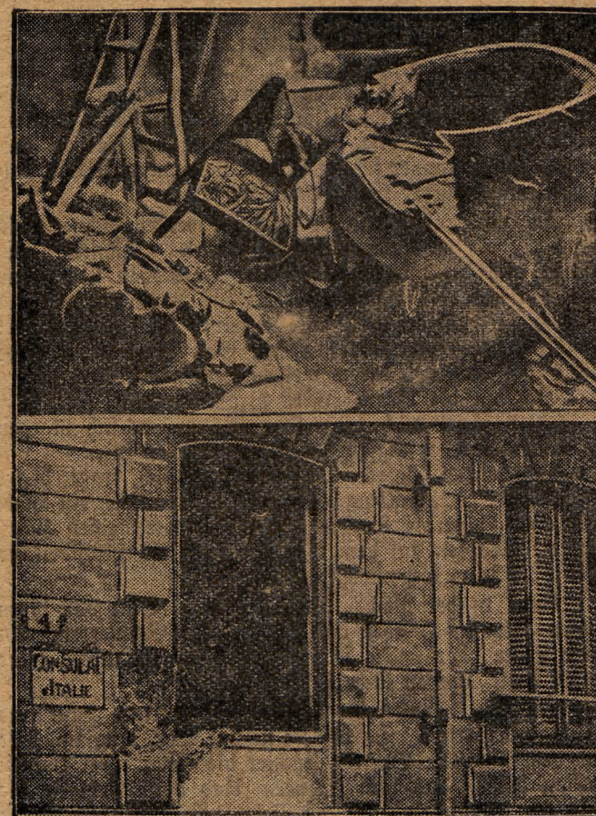
Zum Bombenanfang am 1.11.31 unterirdische Konsulat in Chambery (Frankreich).
