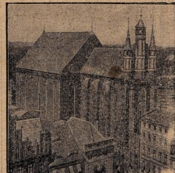
Kirche in Thorn, die infolge von Fundamentverwackung einzustürzen droht.
