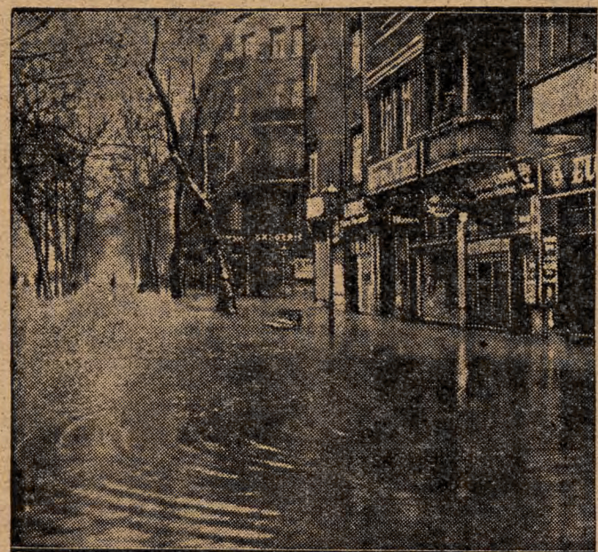
Ueberschneemut wurde eine der belebtesten Straßen in Berlin-Charlottenburg infolge des Platzens von Wasserleitungsröhren.
