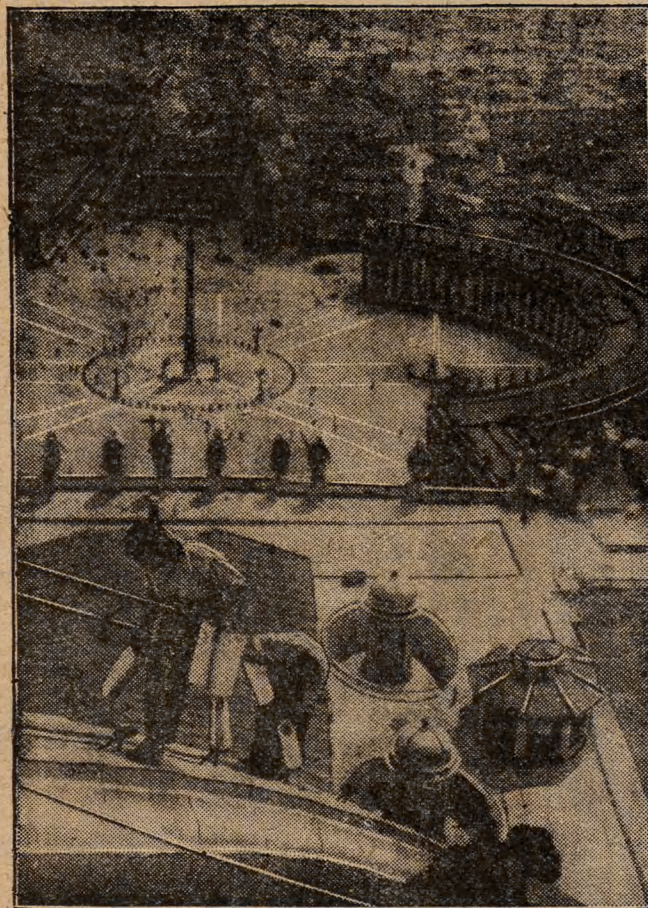
Fronleichnam in Rom. Auf der Stuppel der St. Peter-Kirche in Rom werden elektrische Lampen zur Illumination am Fronleichnamstage angebracht.
