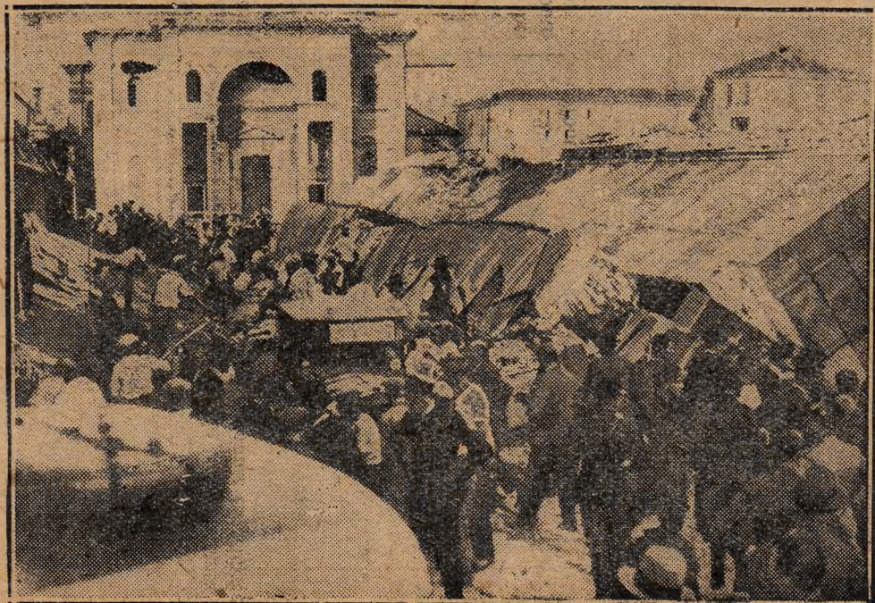
Eine Brücke in Mailand eingestürzt. Bei den Bauarbeiten am alten Bahnhof in Mailand stürzte eine Brücke ein; mehrere Personen wurden getötet, viele verletzt.
