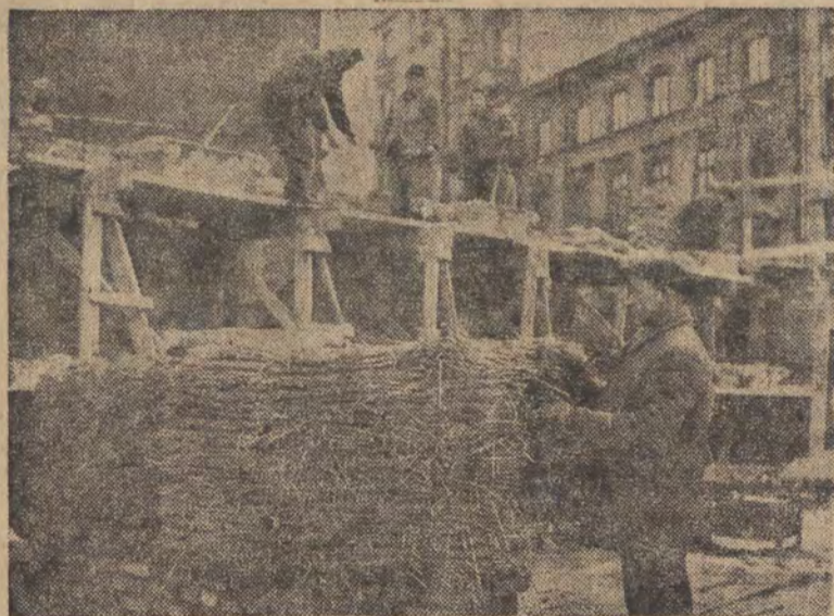
Mury na budowie MDM w Warszawie okrywa się słomianymi mata-mi dla ochrony przed zimnem. Na zdjęciu: Józef Winiarski przykrywa świeżo postawione mury na bloku 3a.
