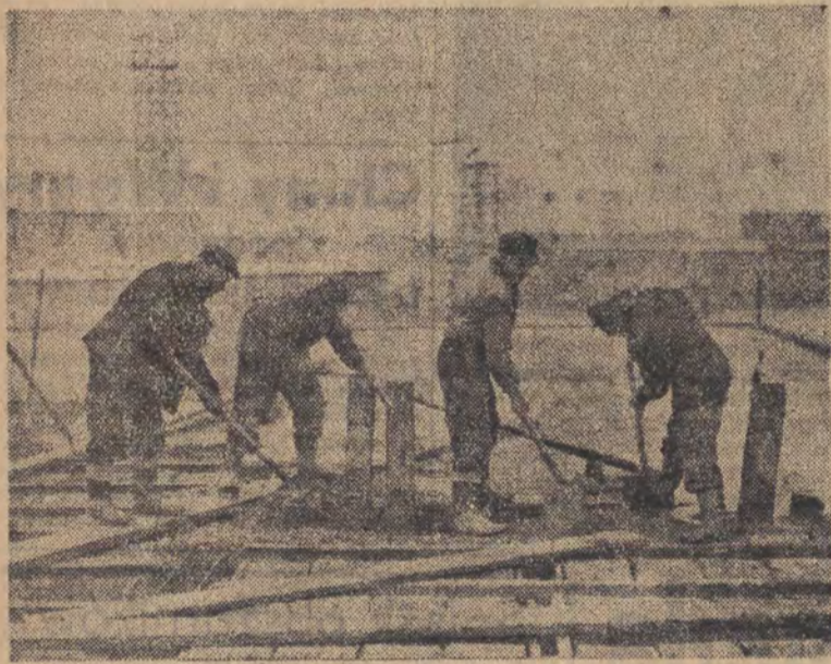
Realizując podjęte zobowiązania, budowlani Nowej Huty wysoko przekraczają normy. Brygada betoniarza Romana Kędziolki osiągnęła w ostatnim okresie obrachunkowym 212 procent normy. Na zdjęciu: członkowie brygady Kędziolki przy pracy. W głębi widoczny las rusztowań szybko budującego się miasta.
