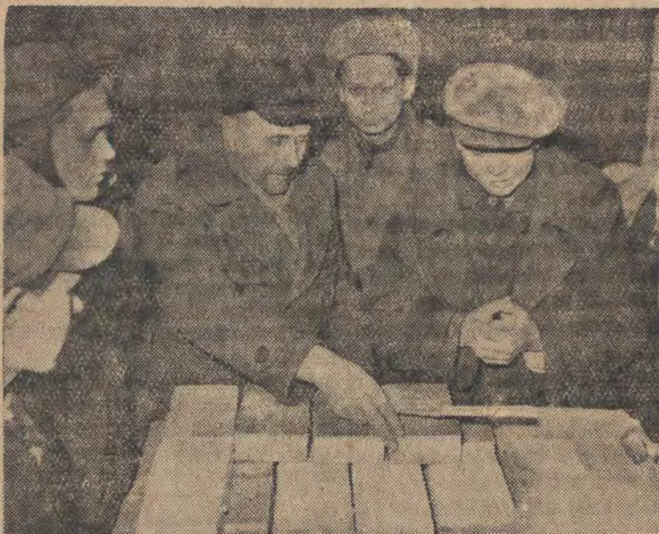
W Warszawie na terenie budowy Marszałkowskiej Dzielnicy Mieszkaniowej rozpoczęła pracę nowoutworzona szkoła stachanowska dla młodych budowniczych MDM. Wykładowcami w szkole stachanowskiej są znani przodownicy pracy: Na zdj.: instruktor Kłos Jakub uczy przyszłych stachanowców równego układania cegieł na narożniku.
