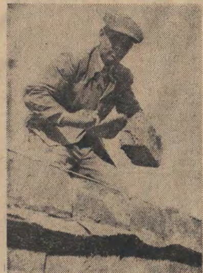
Zaloga Zjednoczenia Budownictwa Miejskiego Warszawy 2, budująca o siedzibie mieszkaniowe na Muranowie 1 Mirowie, pierwsza wśród załóg budowlanych w kraju odpowiedziała na apel Pruszkowa o uczczenie czynnem produkcyjnym tegorocznego Święta 1 Maja. Na zdj.: wielokrotnie przewodnik pracy z budowy Muranowa, murarz Stanisław Cegielski, który ze swą brygadą osiąga do 200 proc. normy. Foto—AR.
