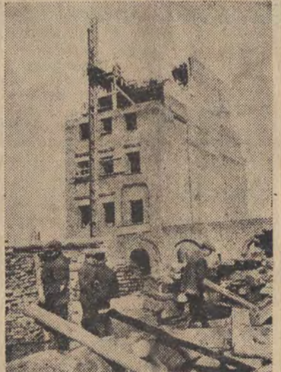
Bez przerwy trwają prace przy odbudowie zabytkowego Rynku Starego Miasta w Warszawie.
