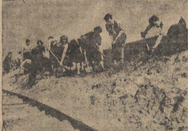
W promieniach wiosennego słońca pracowali studenci pierwszego roku PWSSP przy niwelacji terenu pod budowę nowej zajezdni MZK. Byli to ich Czyn Majowy. Studenci — piasty wykazali nie mniejszy zapał przy robotach ziemnych, niż przy sztalugach.
