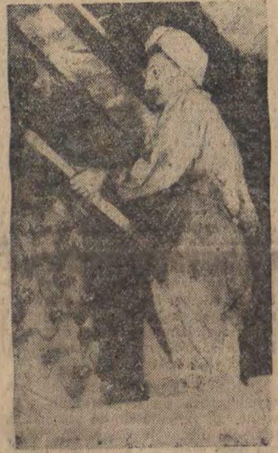
Helena Kunc pracująca przy uszczelnianiu komór wodnych, wyrabia 182 proc. normy.
