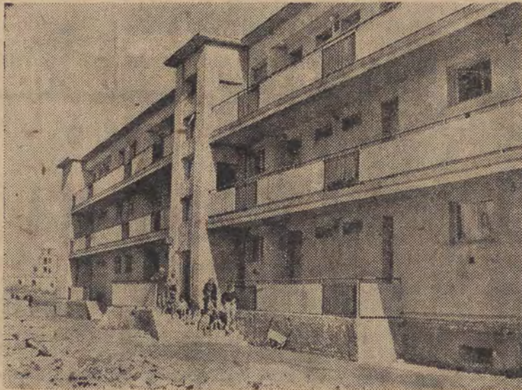
Fragment nowowybudowanego osiedla na Młoczu
