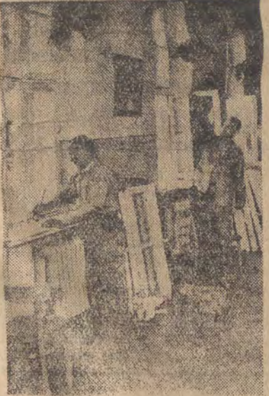
W opustoszałych salach szkolnych wzięto prace. Na terenie całej Polski prowadzone są intensywne prace remontowe na przyjęcie młodzieży szkolnej.
