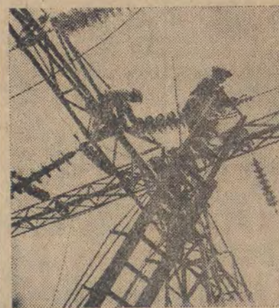
Szybko postępuje praca przy budowie największej w Polsce elektrowni w Dychowie.
