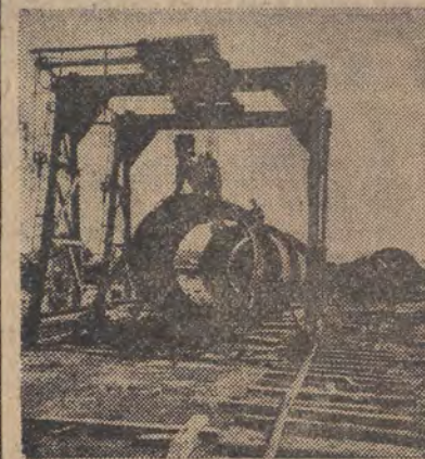
W nowoczesnej, największej w Polsce cementowni w Wierzbicy pod Radomiem, brygady montażowe „Mostostalu” przystąpiły już do montażu poszczególnych elementów olbrzymich pieców cementowych dostarczonych przez Związek Radziecki.
