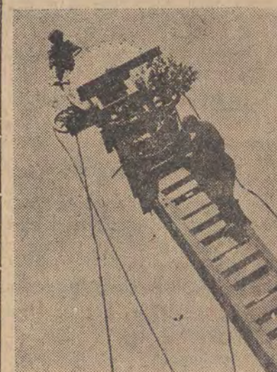
W Goczałkowicach Śląskich przystąpiono do budowy zapory wodnej na rzece Wiśle.
