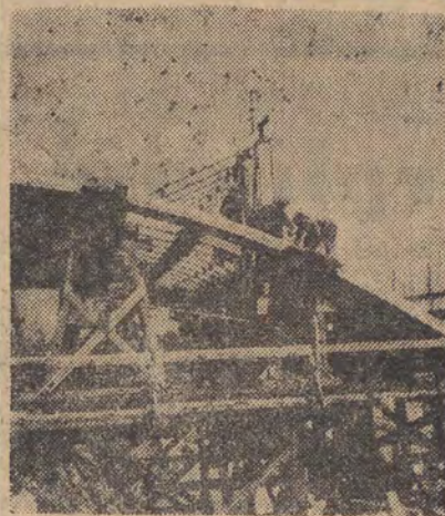
BUDOWA FABRYKI SAMOCHODÓW OSOBOWYCH NA ŻERANIU
