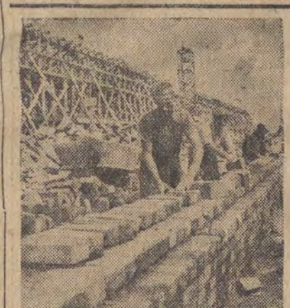
Budowa Fabryki Samochodów Ciężarowych w Lublinie. Na zdjęciu: Brygada murarska Zygmunta Poznańskiego wyrabiająca przeciętnie 180 proc. normy.
