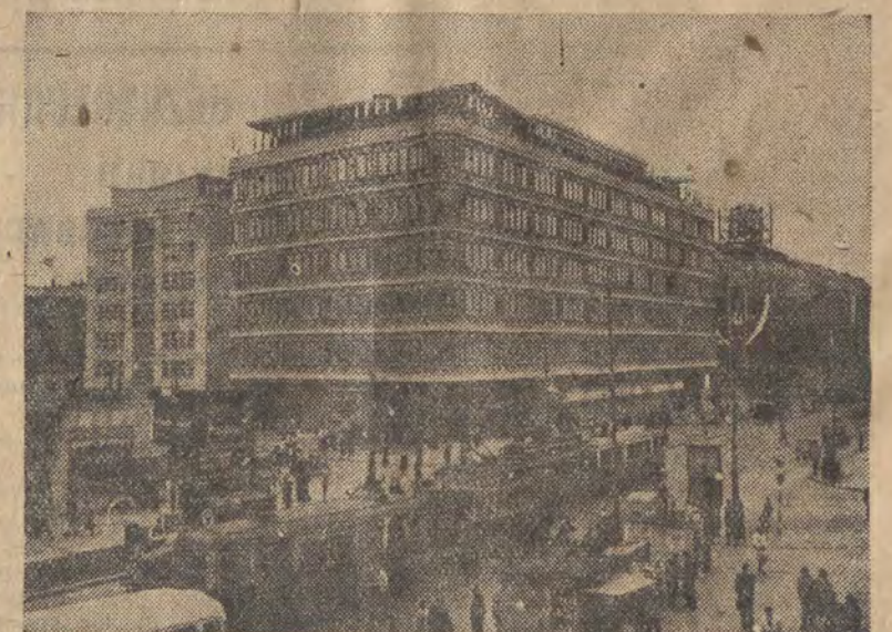
Dnia 22 lipca br. odbyło się uroczyste otwarcie Centralnego Domu Towarowego w Warszawie. Na zdjęciu: Ogólny widok Centralnego Domu Towarowego.
