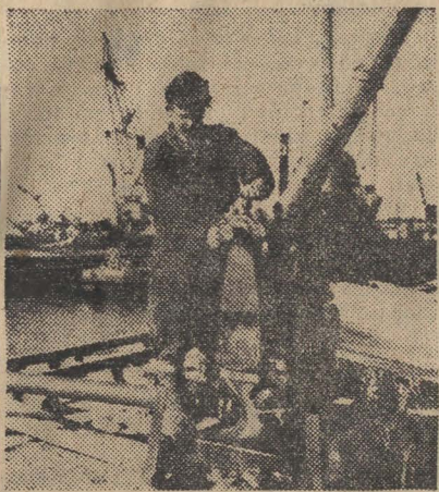
Budowa bazy rybackiej w Świnoujściu.
