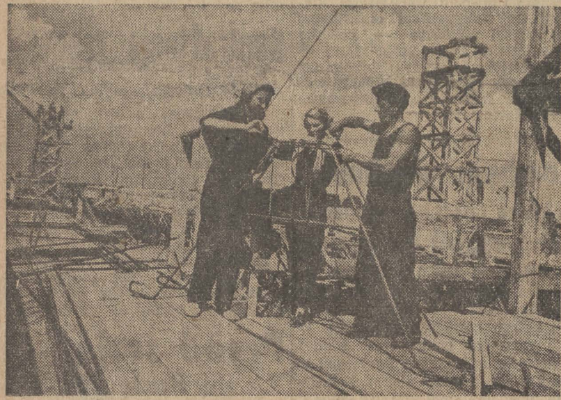
Dzięki współzawodnictwu pracy i pomocy Związku Radzieckiego wzrosło tempo prac przy budowie olbrzymiej Fabryki Samochodów Ciężarowych w Lublinie.
