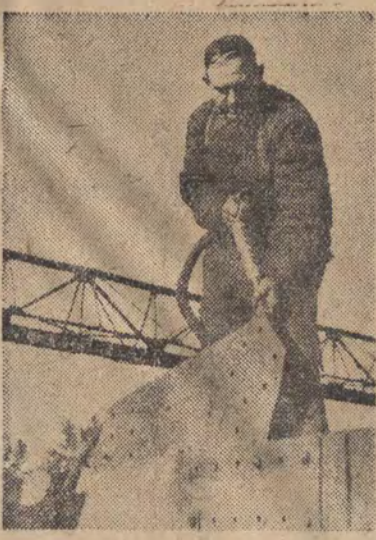
Zakłady Budowy Maszyn i Aparatury w Krakowie. Na zdjęciu: Przy pracy monter Sylwester Sawicki z przodu i brygady Stefana Knuplena. (CAF — fot. Kondracki)
