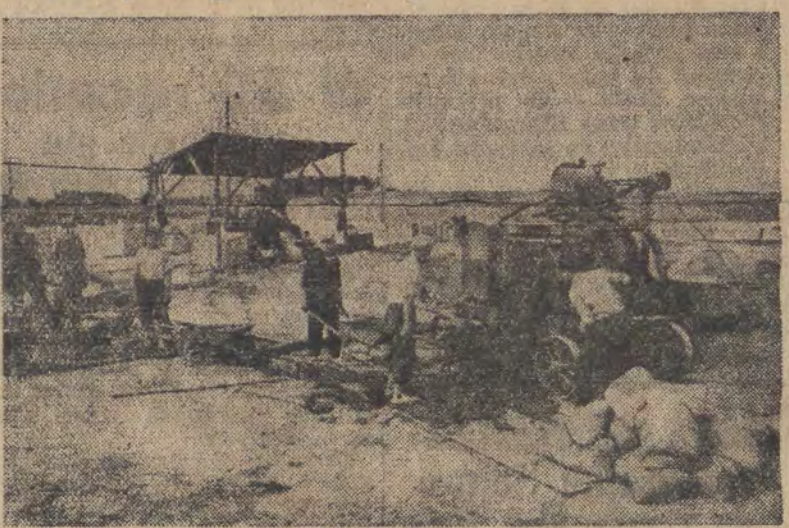
Jedną z wielkich inwestycji Planu 6-letniego jest budująca się wielka cementownia „Rejowiec 2”. Na zdjęciu — przygotowywanie betonu do budowy ław fundamentowych. CAF — fot. Zyg. Wdowiński
