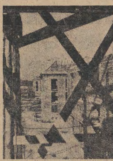
Na terenie miasta Nowe Tychy prowadzone są prace wykończeniowe przy budowie pierwszego dwudziestu bloków mieszkalnych. Na zdjęciu: Fragment budowy. (CAF — fot. Kondracki)
