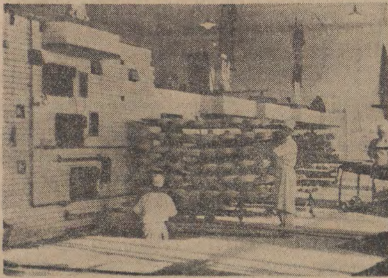
W dniu 34 rocznicy Wielkiej Rewolucji Październikowej, została uruchomiona w Łodzi piekarnia-gigant, której dzienne produkcja wynosi ca 33 ton pieczywa. Na zdjęciu: Fragment wewnętrznych urządzeń piekarni. CAF — fot. Szafrharc
