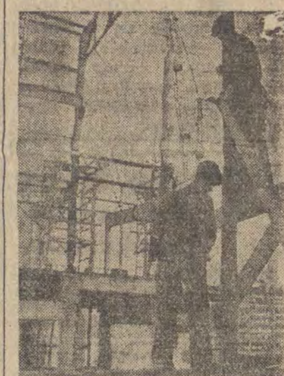
Na zdjęciu: Dwa ciśnie przodownicy pracy. Stefan Owczarek i Władysław Majcherek z brygady ślusarskiej Franciszka Dudka, wyrabiający przeciętne 300 proc. normy, ustawiają rusztowanie dla montażu sklepieniowej konstrukcji stalowej — w głębi montaż wiązań sklepienia stalowego nowej elektrowni. CAF — fot. Baranowski
