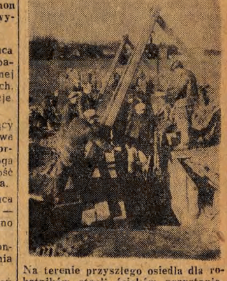
Na terenie przyszłego osiedla dla robotników stacji ściekowej przystąpiło już do robót kanalizacyjnych.
