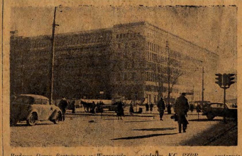
Budowa Domu Partyjnego w Warszawie — siedziby KC PZPR — postępuje szybko naprzód. Został już całkowicie wykonany front wzdłuż ul. Nowej Świata. Obecnie trwają prace przy okładaniu białym marmurem fasady wzdłuż ul. Sikorskiego
