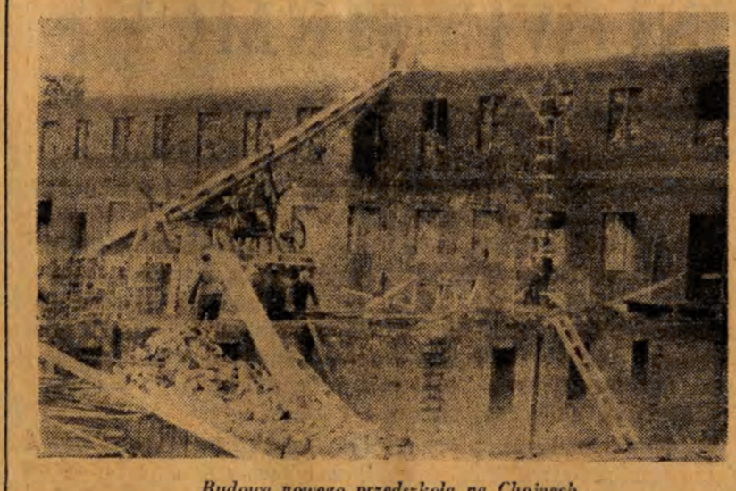
Budowa nowego przedszkola na Chojnach
