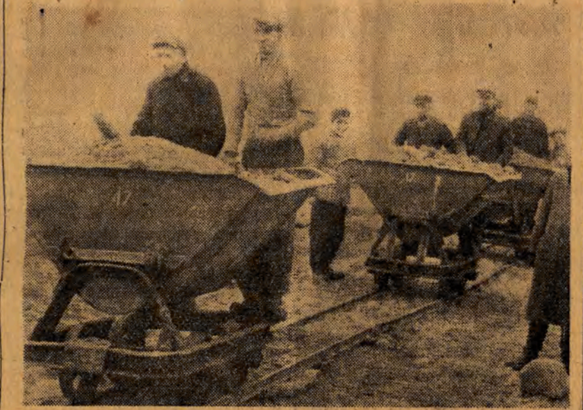
Na przedłużeniu ul. Uniwersyteckiej — Strykowskiej trwają roboty przy niwelacji terenu.
