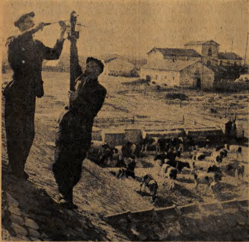
Grupa techniczna PGR — Wilanów zakłada instalacje elektryczne w obszarze. Na zdjęciu: Członkowie grupy: Mieczysław Kawecki (po lewej) i Jerzy Młotek (u dołu) zakładają zewnętrzne przewody elektryczne. (CAF fot. Nowosielski)
