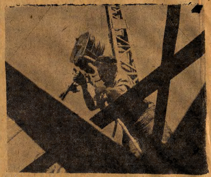
W szybkim tempie powstaje jedna z wielkich budowli Planu 6-letniego — Cementownia Wierzbice. Na zdjęciu: Władysław Sarna przy montażu dźwigu portalowego o nośności 40 ton, który będzie służyć do montowania pieca obrotowego cementowni. (CAF, fot. Zygm. Wdowiński)
