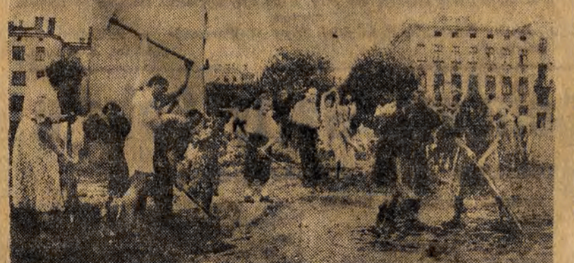
Wspaniała autostrada łódzka zamieni się wkrótce w barwny kwiatnik. Pracują tutaj w dni wolne od zajęć - pracownicy wielu łódzkich instytucji. Na zdjęciu: personel Hal Targowych PSS zajęty przy niwelowaniu Placu Pokoju na autostradzie.
