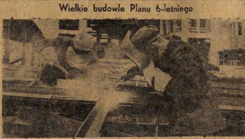
Pracownicy pracy na budowie wielkiej siłowni w Jaworznie, wyrabiający 318 procent normy: spawacz Kazimierz Uguś i Kazimierz Łagan, spawający stalową konstrukcję do maszynowni (CAF fot. Baranowski)
