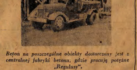
Beton na poszczególne obiekty dostarczany jest z centralnej fabryki betonu, gdzie pracują potężne „Regulusy”.
