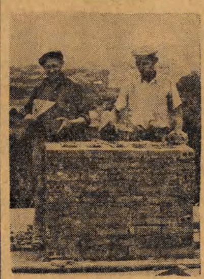
W szybkim tempie posuwa się praca murarska na budowie IX Domu Akademickiego przy ul. Bystrzyckiej. Na zdjęciu: dwójka murarska w składzie Feliks Majchrzak i Bernard Bawonowski, która wykonuje przeciętnie 200 proc. normy.
