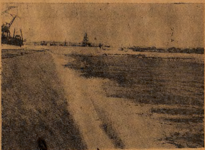
Na terenie budowy hydroczłwa cymlińskiego wody Donu spływają po raz pierwszy w nowe koryto rzeczne.
