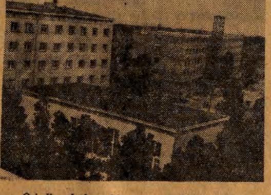
Osiele akademickie przy ul. Bystrzyckiej — w budowie
