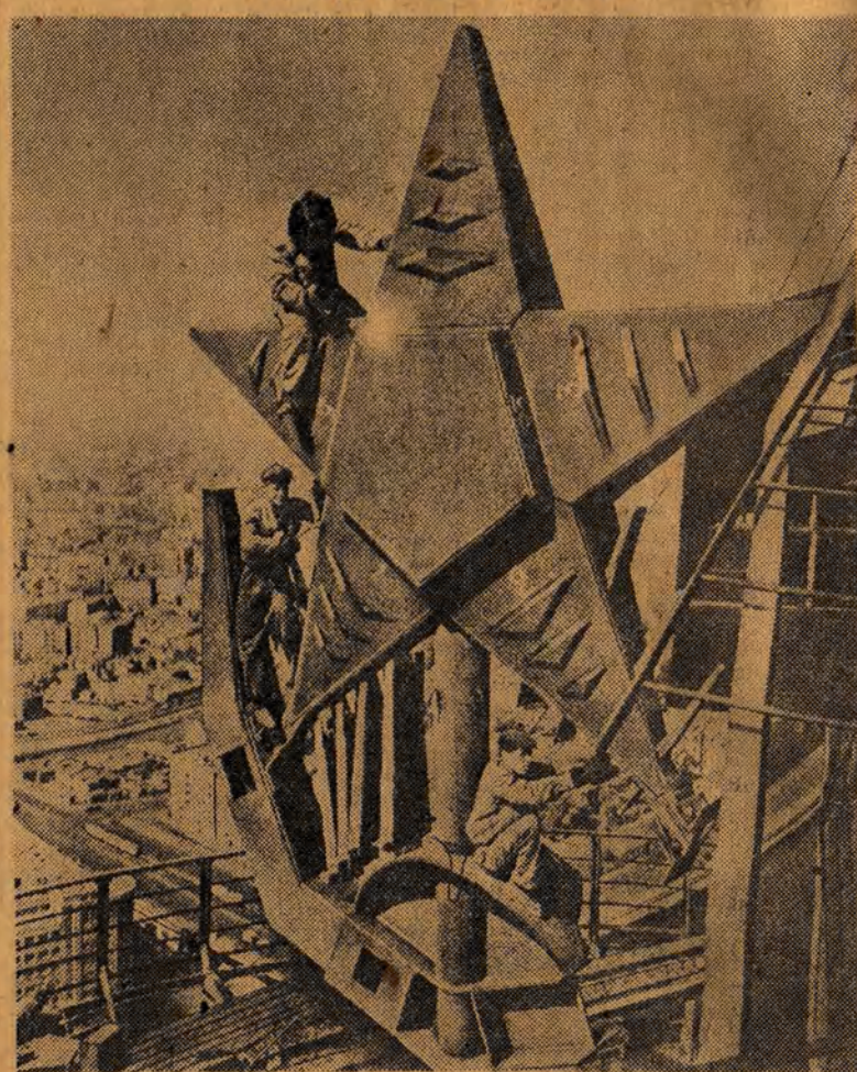
Końcowe prace przy budowie wieżowca — na kotłowni nabrzeża w Moskwie. Robotnicy montują na wysokości 136 metrów godło Związku Radzieckiego.
